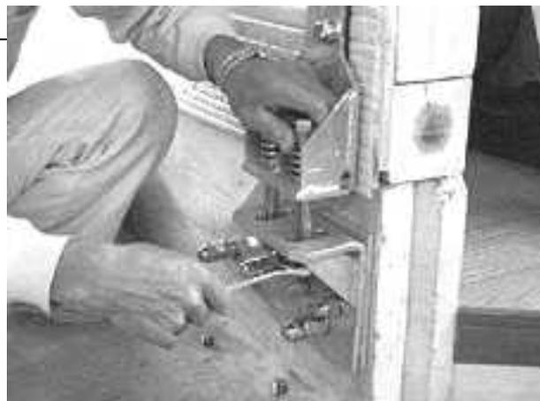
**要注意** ダブルナットで連結する際に、強く締めすぎるとハイテンションスプリングが縮み過ぎますので、若干縮む程度に調節しながら連結して下さい。
