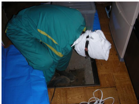
■床下収納庫からの調査
