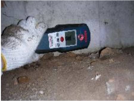
■基礎の有筋・無筋の確認
