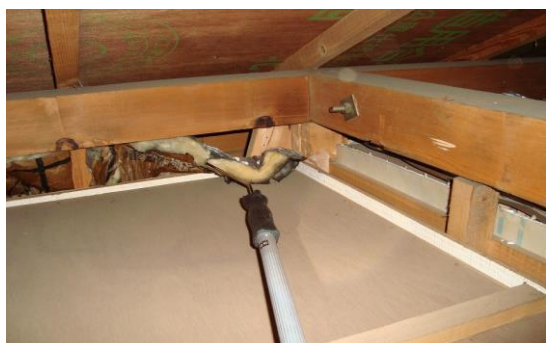
■筋かいの確認(断熱材の裏側)
