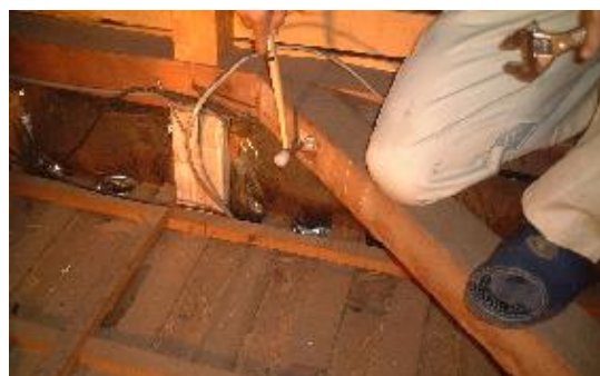
■火打ちの確認(ボルトの有無)
