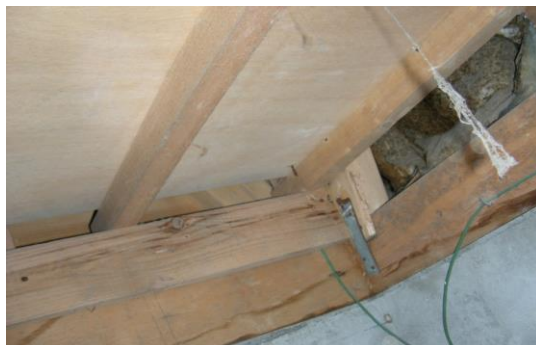
■筋かい端部接合金物の確認
