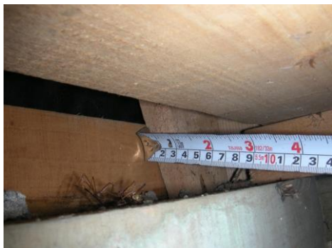
■筋かい断面の確認
