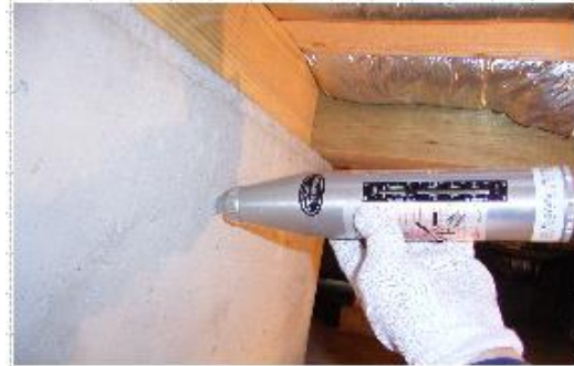
■基礎の圧縮強度の測定
