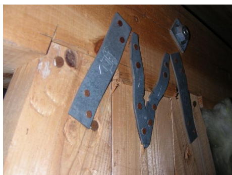
■接合金物の様子(山形プレート・ひら金物)
