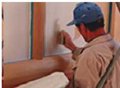
【コテ塗り施工】
