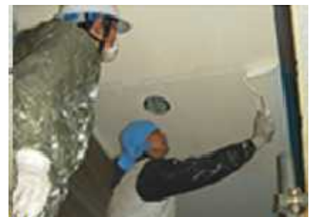
【ローラー施工】
