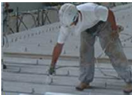
【吹き付け施工】
