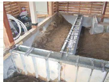
基礎新設工事のイメージ
