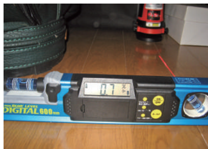
建物の傾斜の測定はデジタル水平器(手前)やレーザー(右奥)を用いる
