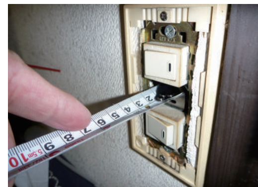
写真② 壁の仕様(素材や厚さ)を確認するためにスイッチプレートのカバーを外したところ
