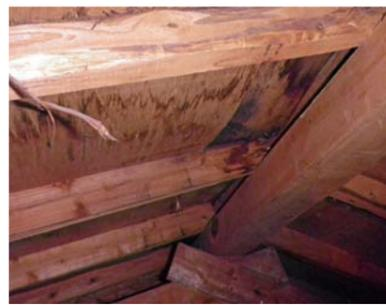
写真① 雨水が小屋裏へ浸入している
