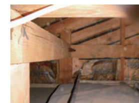
小屋裏(筋交いの確認)
