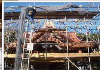
◀小動神社 (こゆるぎじんじや) の屋根軽量化工事
