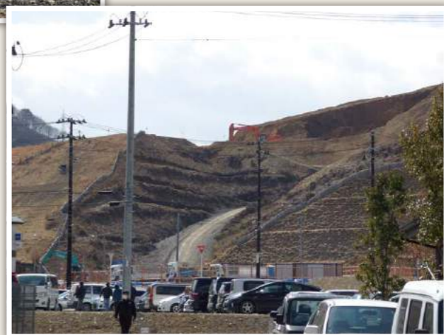
▲山を切り開き高台へと工事中
