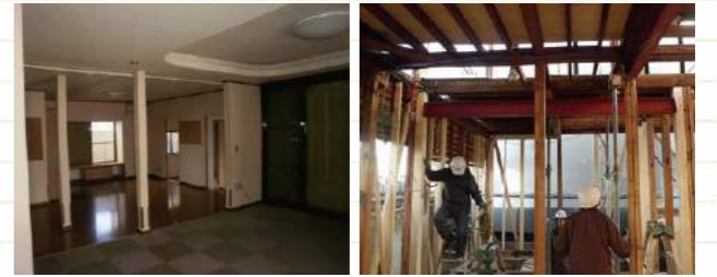
柱を抜く前 柱を抜き、梁を補強した後
