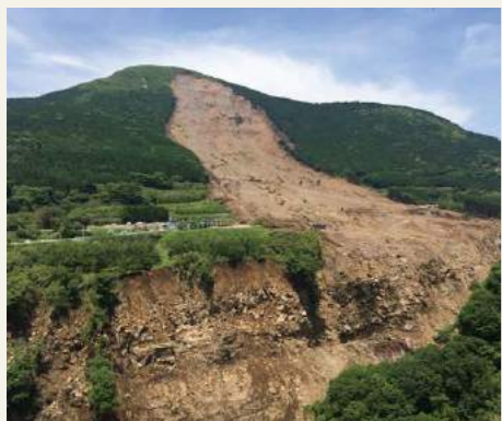
▲大規模土砂災害(阿蘇大橋の崩落)
