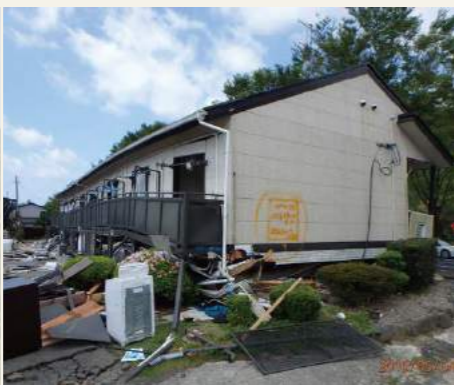
▲木造共同住宅の倒壊(南阿蘇村)
