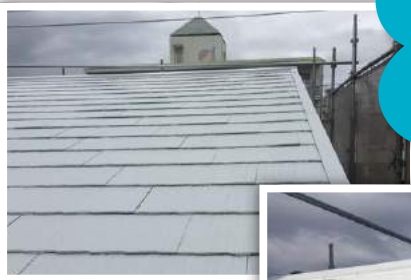
▶▲屋根に節電塗料を塗布した現場
