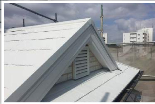
▶▲屋根に節電塗料を塗布した現場
