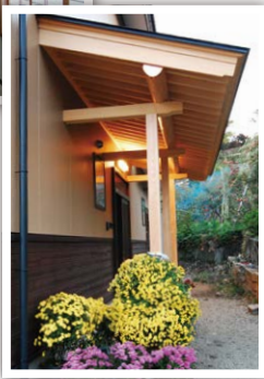
◀磨き丸太の施工例
