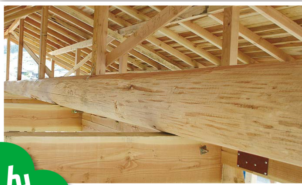
▲伝統的な中曳き(なかびき)梁の施工例
