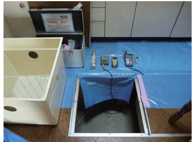
写真⑤：床下進入路周りの養生の様子。床下収納庫から進入。ビニールシートや養生テープでしっかりと養生を。
