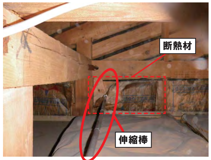
写真③：小屋裏で伸縮棒を使い、断熱材をはがしているところ。伸縮棒は手の届かない場所の筋かいを確認するために重宝する。
