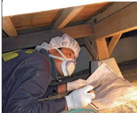
【写真③】 ▲床下の調査風景。床下や天井裏の確認は家の歴史(劣化状況)を知る上で重要だ
