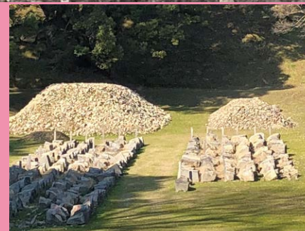
石垣復旧のために並べられた石材
