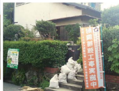
◀耐震補強現場にのぼりを掲示
