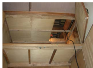
▲天井点検口から天井裏を覗いて調査
