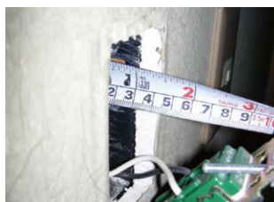
▲コンセントカバーを外し面材を確認
