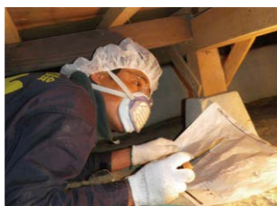
▲床下収納庫等から床下調査
