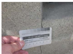
▲内壁仕上げ材の確認
