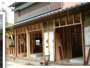
▶▶ 施工事例:在来工法補強工事
