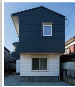
▲施工事例2:Q値1.2・C値0.1
