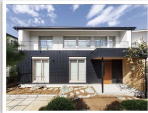
▲施工事例1:Q値0.9・C値0.15
