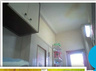
▶屋内の赤外線調査
