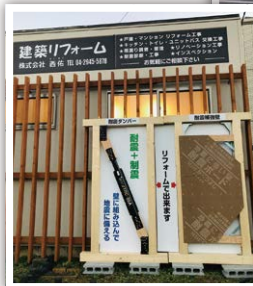
◀制震TRCダンパーとかべつよしの 躯体を通りから見えるように展示
