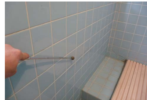
【写真⑦】浴室タイルのひび割れや浮きの調査には、打音検査棒を用いる
