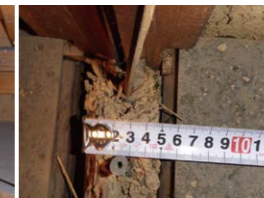
【写真⑥】土塗りの厚みの確認
