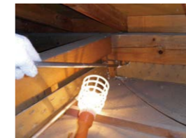
【写真⑤】筋かいの確認
