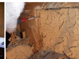
【写真④】筋かいの確認
