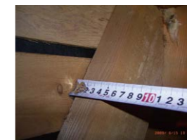
【写真③】筋かいの厚みの確認
