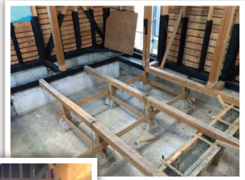
▲取材当日は基礎の工程
