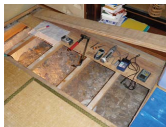
【写真②】和室が畳敷の場合は、まずは畳を上げ、下地板を外して床下へ進入
