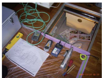
【写真②】和室が畳敷の場合は、まずは畳を上げ、下地板を外して床下へ進入
