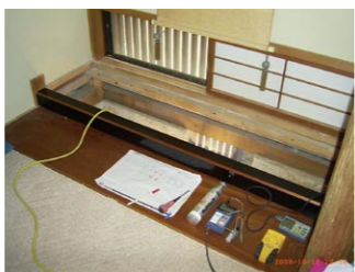
【写真④】床の間の畳床からも進入できることもある
