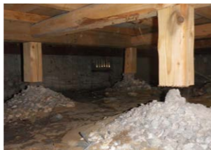
▲風化した束石。場所によって、束から離れ浮いてしまっている
