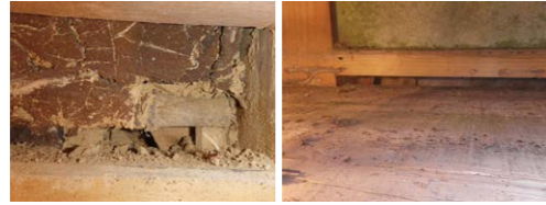
▲土塗り壁の場合には、柱脚部分の土を削って確認するか、ドライバーなどで触診する ▲和室であれば、畳を剥がして、雑巾ずりと下地板の隙間から確認できることもある
