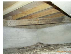
▲火打ちの有無、床下地の仕様(荒板等)を確認。床仕様によって、耐震評価も異なってくるので要注意
