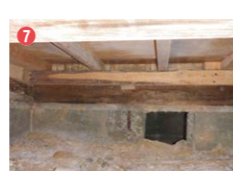
⑦床下の調査は、床下内部の換気口や根がらみを潜り抜けていかなばならず、運動量もかなりのものになる
