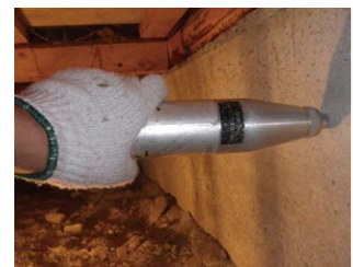
【写真⑤】 コンクリートテストハンマーによる基礎強度の測定。写真撮影上、片手で持っているが、実際は両手でしっかり固定して基礎に衝撃を与えて、その反発力を測定する
