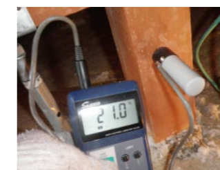
【写真③】 土台や大引き同様、地面に近い束についても数箇所測定する
