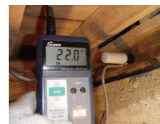
【写真②】 床下の土台や大引きといった構造材の含水率を測定し、白アリからの被害を受けやすい状態かどうか確認する
