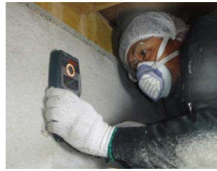
【写真④】 基礎のコンクリートに鉄筋が入っているか否かは、基礎の強度、ひいては耐震診断結果に影響するのでしっかり確認を。アンカーボルトを基礎の鉄筋と間違わないように注意
