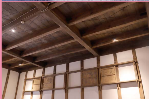
↑ 1階天井に補強金具を設置
