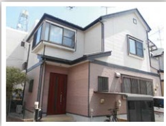
▲塗装工事の施工前
