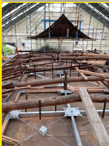
天井補強の様子
