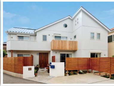
2世帯住宅の施工事例
