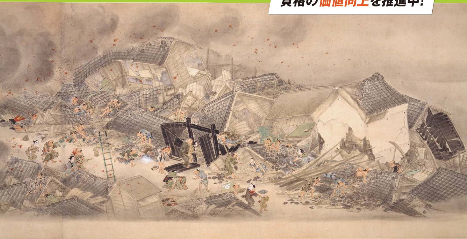
▲建物が倒壊し、人々が避難する様子。左手には火災による煙が上がっている
