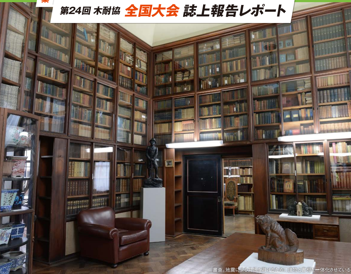
書斎。地震による共振を避けるために建物と書棚を一体化させている
