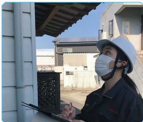
▶耐震診断の様子
