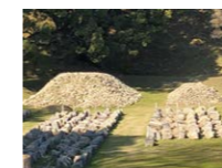
▲崩落した石垣は、寸分たがわぬようにパズルのように組み合わせて再建する。
