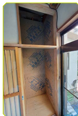
▶「MDFかべつよし」を用いた壁補強
