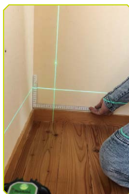
▶屋内調査、傾きを測定
