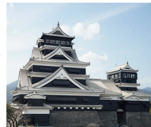
▲天守閣は1960年に再建されたRC造なので、復旧が早く進んだ。 ※写真提供: 熊本城総合事務所
