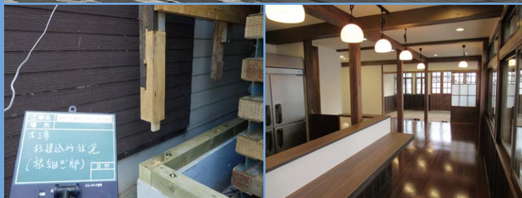
▲改修中（柱の根継ぎ）
