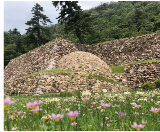
▲鳥取城の見どころの可愛い巻石垣。1800年頃、石垣の崩落を防止するために築き足された
