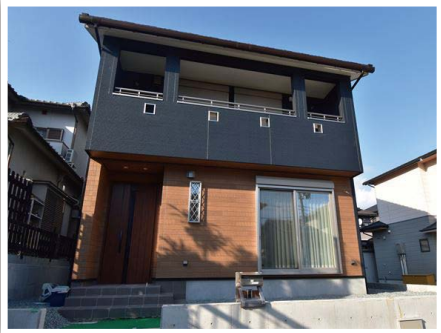
▼新築の施工事例
