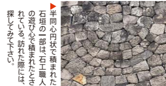
▶現在の白河小峰城修復は石垣の殆どが崩壊した石積み技術で行われた
