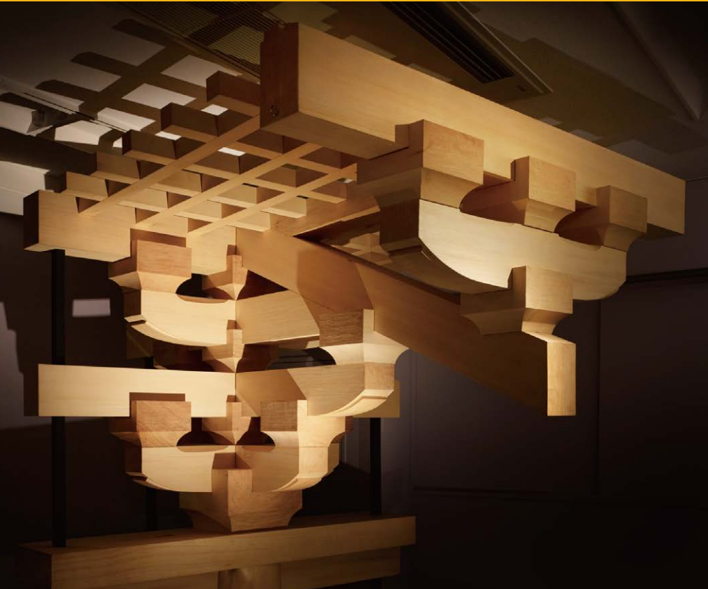
▲薬師寺三重塔の初重斗組（しよじゅうますぐみ）部分の大型模型
