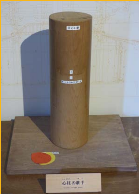
▲心柱の継手。手で触れ、外してみることもできる
