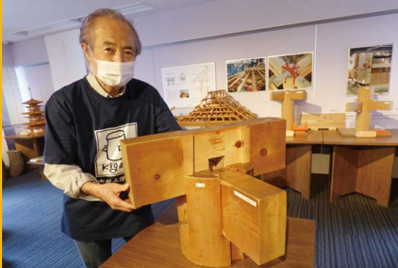
▲谷川館長に穴八幡宮随神門の木組模型を外してみせていただく
