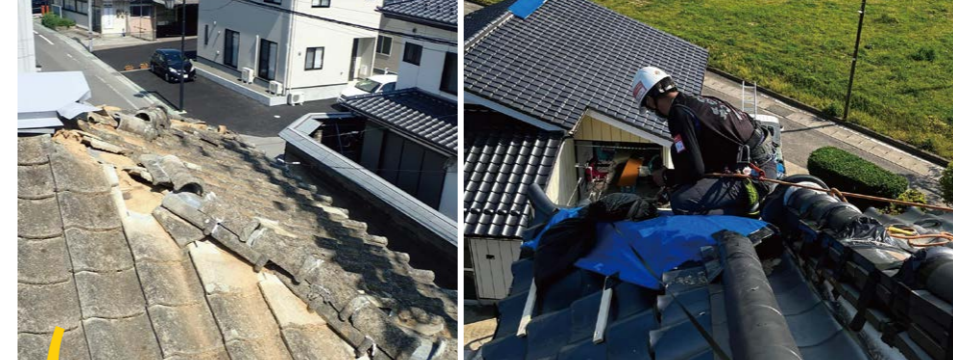
▲応急処理前の屋根 ▼応急処理後 ▲二階の軒先は、危険な作業になります
