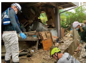
▲豪雨被害にあった 家屋の泥かき作業 (2020年7月九州豪雨)
