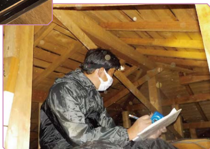
▶小屋裏調査の様子
