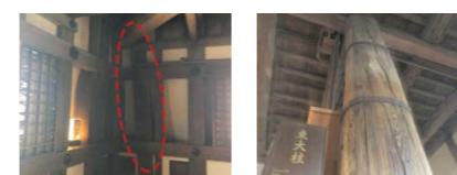
▲伝統工法に巨大筋交いが?!これは明治の大修理の時に補強されたもの ▲天守を支える東西の2本の柱は、直径1mの地下1階から6階までの通し柱
