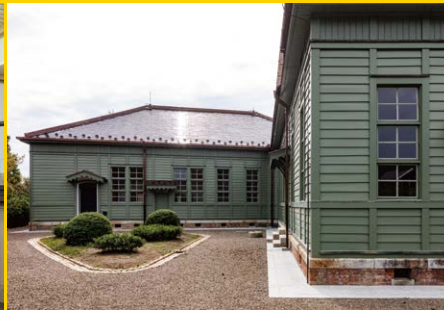
▲切手倉庫。史料に基づき当初の構造であるレンガ積みに復原した
