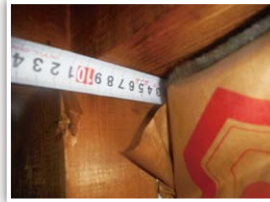
▲断熱材の厚みや気流が生 じる隙間、サーモグラフィ での撮影など
