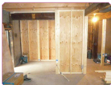
▶耐震補強工事中
