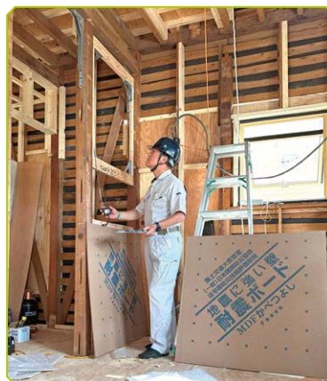
◀耐震補強工事中
