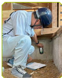
◀基礎の鉄筋検査の様子
