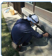
▼基礎の鉄筋検査の様子
