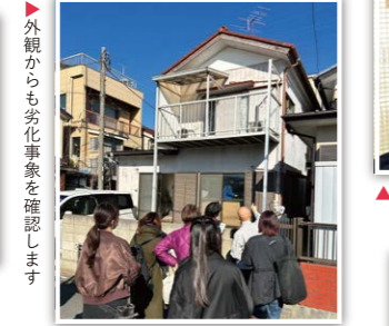
▲外観からも劣化事象を確認します
