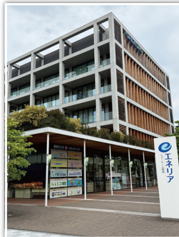
▲事務所兼ショールーム
