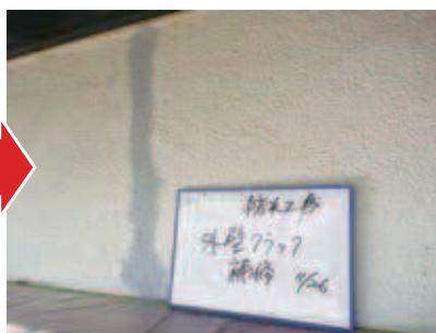
外壁ひび割れ補修後
